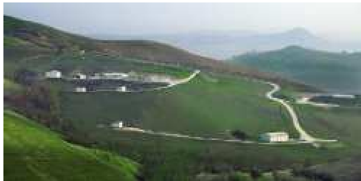
Fig.23 – Sede Deposito Alessi Firework in località La Spineta
