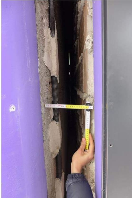
*Figura 12: giunto sismico in corrispondenza di una quota intermedia tra due solai*
