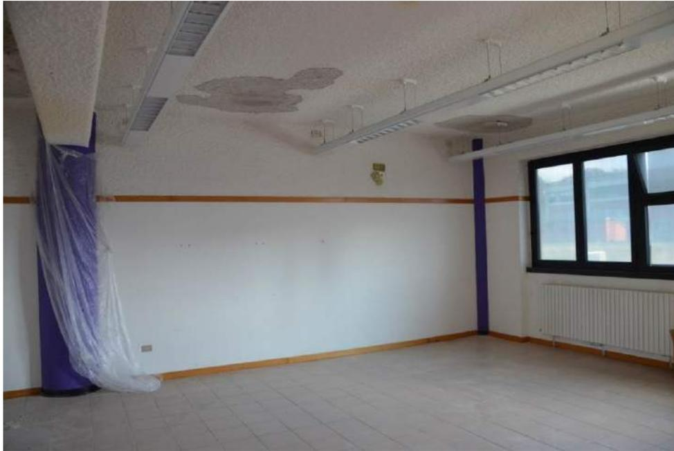
*Figura 25: degrado del soffitto per infiltrazioni dal terrazzo sovrastante*
