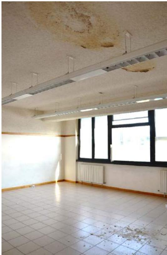
*Figura 22: degrado e distacco dell'intonaco fonoassorbente per infiltrazioni dal terrazzo sovrastante*
