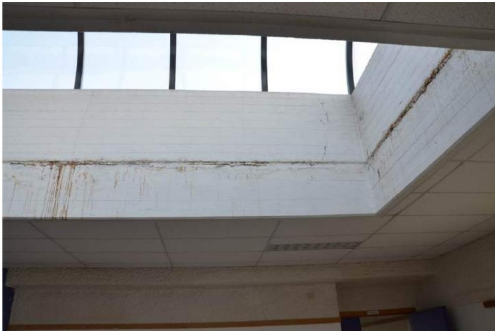
*Figura 24: infiltrazioni dal giunto di ripresa del getto del muro in cls*
