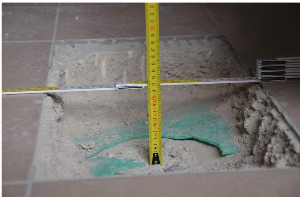
*Figura 8: indagine per la determinazione dello spessore del massetto e pavimentazione*
