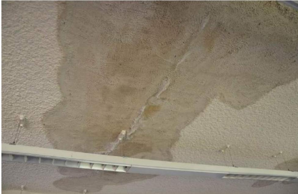
*Figura 21: degrado del soffitto per infiltrazioni dal terrazzo sovrastante*
