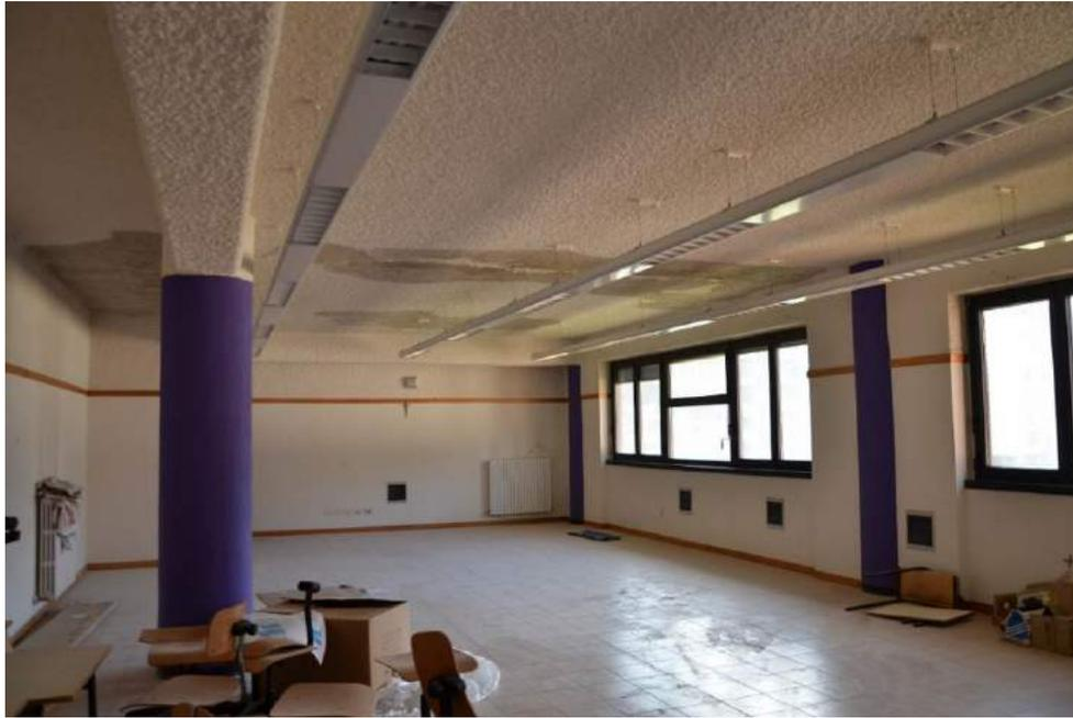
*Figura 23: degrado del soffitto per infiltrazioni dal terrazzo sovrastante*
