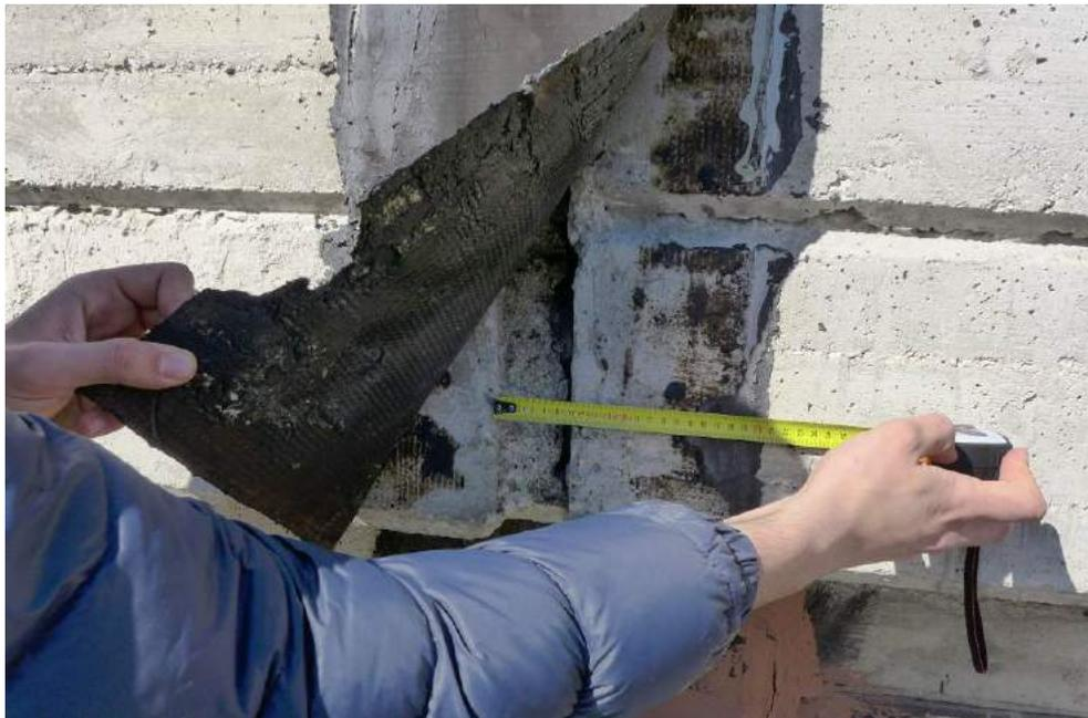
*Figura 13: giunto sismico in corrispondenza del solaio di copertura*
