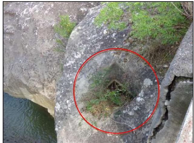
Fotografie 9-10: lo sbarramento a valle e l'incasso quadrangolare sulla roccia per la trave di sostegno di un ponte nel settore 3
