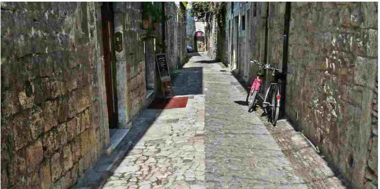
**4 – Tipologia di pavimentazione in ciottoli di fiume disposta a schiena d’asino.
