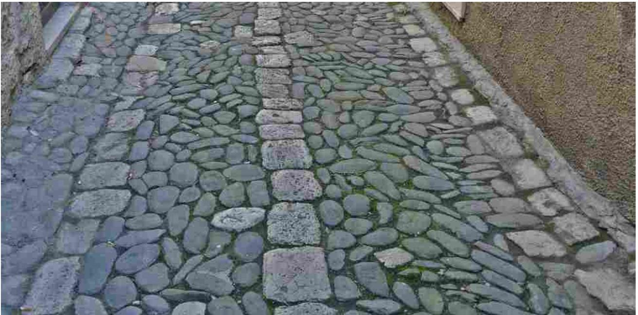
**6 – Tipologia di pavimentazione in ciottoli di fiume disposta a schiena d'asino con canalette e asse centrale in travertino squadrato.**
