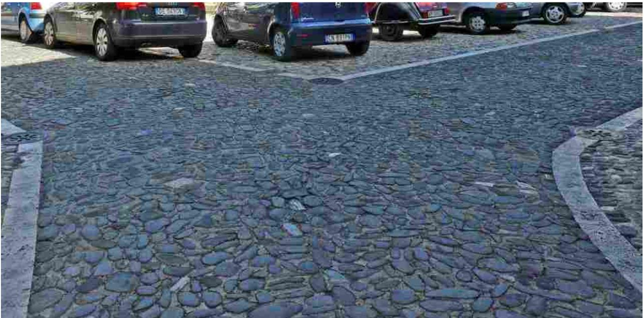
**16 – Zona S. Tommaso. Recente intervento di rifacimento della pavimentazione in ciottoli di fiume con materiale di recupero e inserimento di nuove canalette in travertino, con caditoie secondo il disegno storico.**
