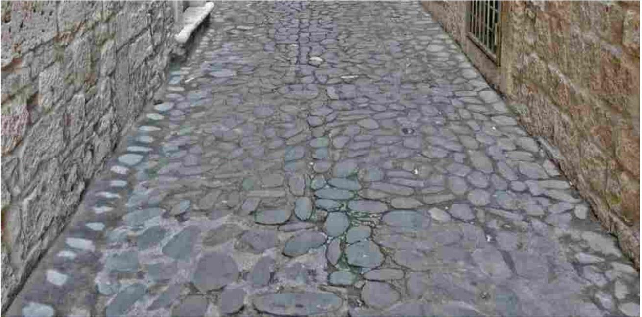
**3 – Tipologia di pavimentazione in ciottoli di fiume disposta a schiena d’asino.**
