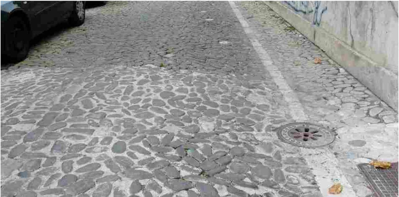
**17 – Zona S.Tommaso. Recente intervento di rifacimento della pavimentazione in ciottoli di fiume con inserimento di nuove caditoie in ghisa ottenute a stampo da quelle più antiche.**
