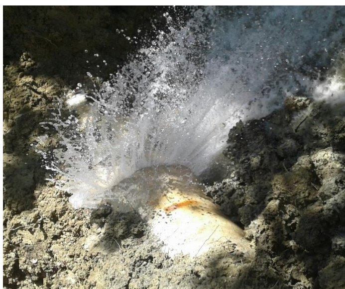
Sisma 2016: Rottura condotta Acquedotto Pescara
