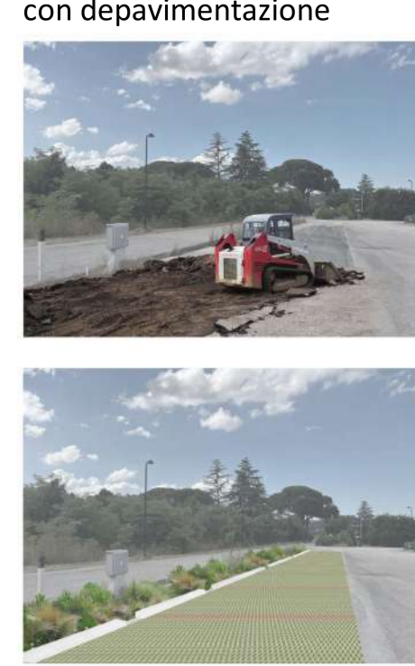
Parcheggi drenanti con depavimentazione
