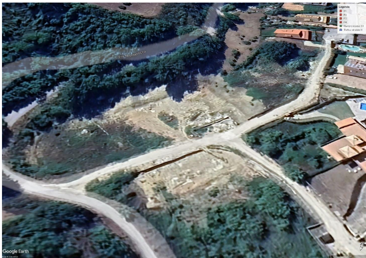
Edificio oggetto di ristrutturazione
