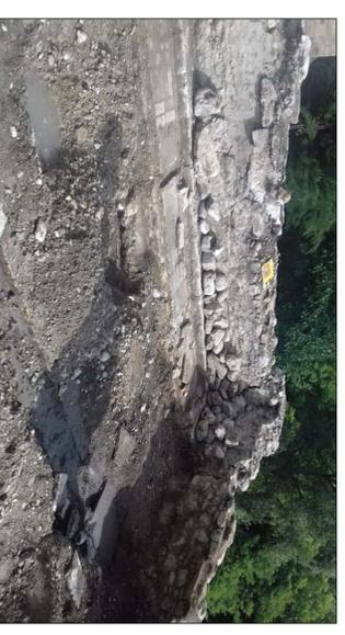
F4 - Area sul lato nord a seguito della frangente di oltre metri 1 di terreno. Si vede l'andamento del muro di confine della proprietà privata. La porzione esaminata in mano propria risulta essere la parte rimanente della porzione esaminata in mano propria. È probabile che i mattoni coprono l'abbeveratoio in travertino segnalato nel progetto di sopralluogo del ponte del 1850, redatto dall'ing. Gabrini, i cui bordi sarebbero visibili nella foto. I saggi effettuati confermerebbero tale ipotesi.
