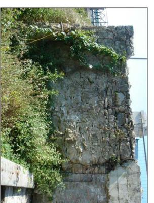
F5 - Spigolo esterno del muro controterra in travertino e salsi di fiume
