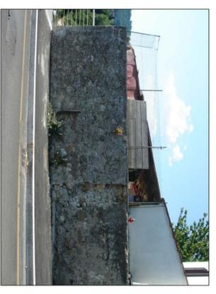
F2 - Collegamento percorso ponte con pista ciclabile. Muro di separazione da proprietà privata. Sono visibili i segni dello smontaggio di uno dei due piedritti di accesso alla città al fine di garantire la continuità del percorso
