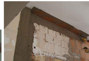
6. Applicazione di rete in fibra di vetro alcali resistente apprettata sull'intera area trattata avendo cura di far penetrare la malta già applicata all'interno delle maglie della rete (vedi schema di Figura 4)
