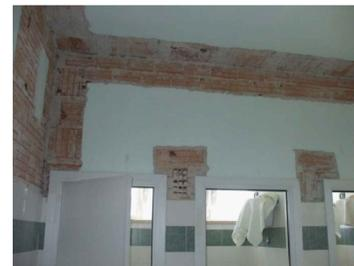
2. Depolverizzazione delle superfici di intaglio e lavaggio con acqua a bassa pressione in guisa di avere le superfici umide prima dell'esecuzione delle fasi successive.
