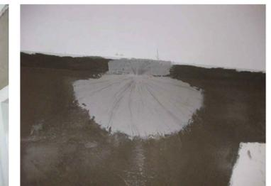
7. Applicazione di un secondo strato di malta cementizia a reattività pozzolanica bicomponente per uno spessore di circa 6 mm sulla intera superficie sulla quale è stata applicata la rete in fibra di vetro. Nell'applicare la malta si avrà cura di lasciare a vista una superficie di rete di dimensioni 10x10 cm intorno a ciascuno dei fori realizzati precedentemente (vedi schema di Figura 5)
