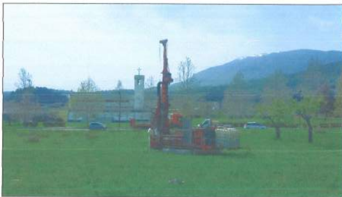
Punto fotografico nr. 5: Esecuzione sondaggio SS2 a carotaggio continuo - Vista da nord.
