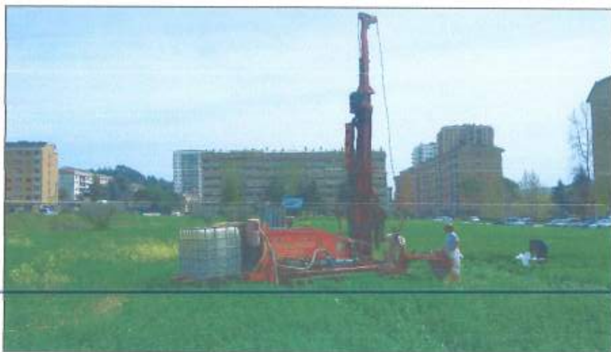
Punto fotografico nr. 12: Esecuzione sondaggio SS3 a carotaggio continuo - Vista da ovest.
