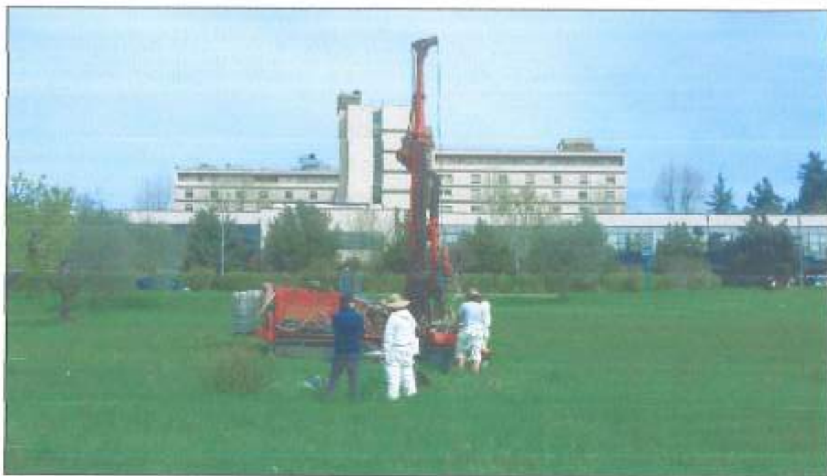
Punto fotografico nr. 7: Esecuzione sondaggio SS2 a carotaggio continuo - Vista da sud.
