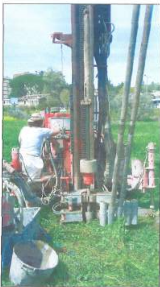
Foto nr. 7: Sondaggio SS4 - Esecuzione prove penetrometriche dinamiche in foro SPT1, SPT2.
