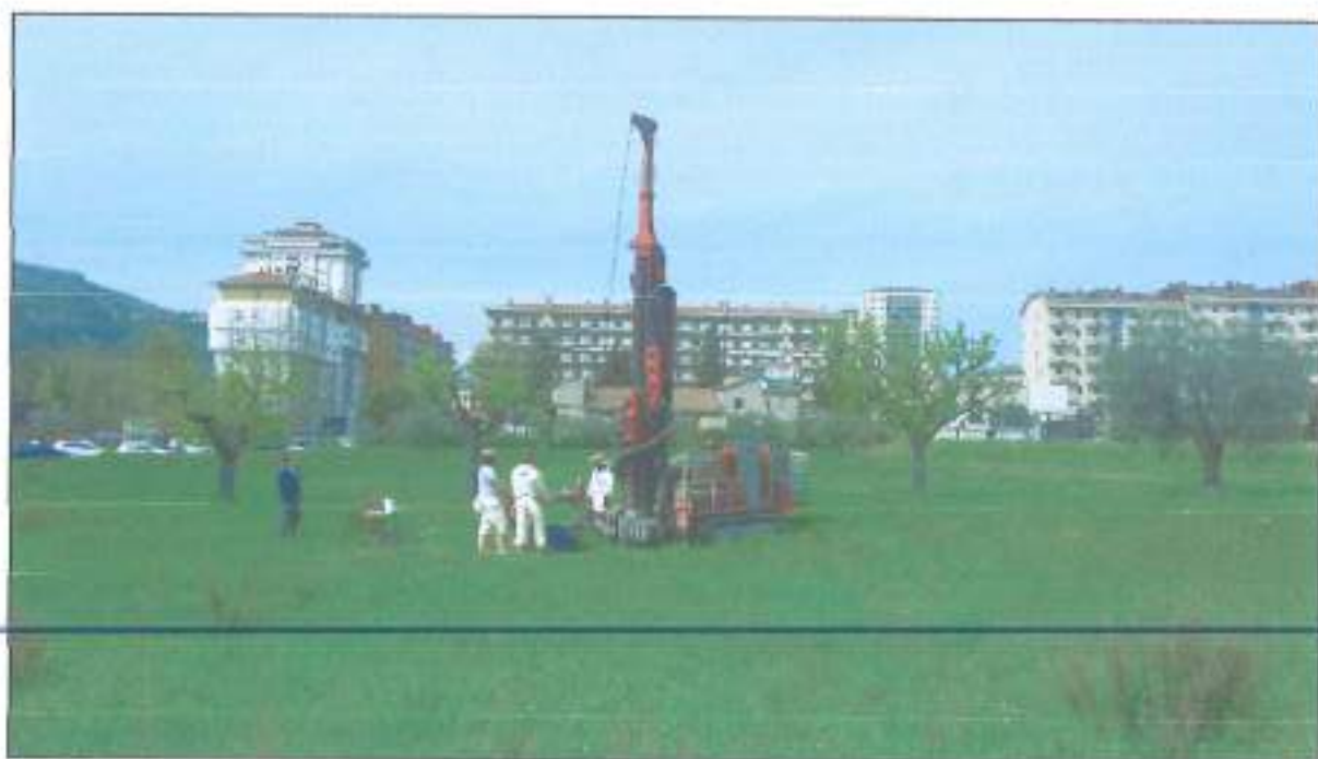
Punto fotografico nr. 6: Esecuzione sondaggio SS2 a carotaggio continuo - Vista da est.
