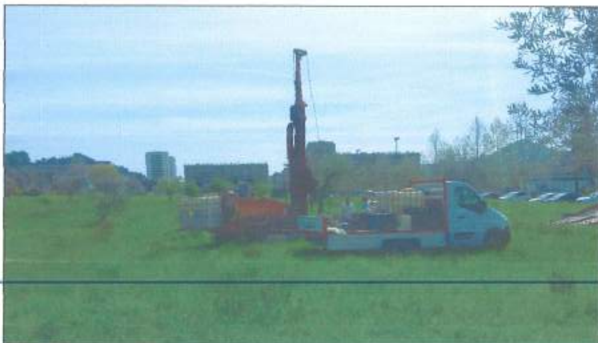
Punto fotografico nr. 4: Esecuzione sondaggio SSI a carotaggio continuo - Vista da ovest.
