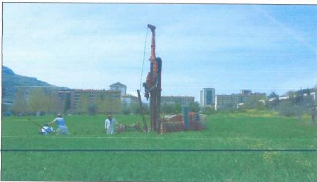
Punto fotografico nr. 14: Esecuzione sondaggio SS4 a carotaggio continuo - Vista da est.
