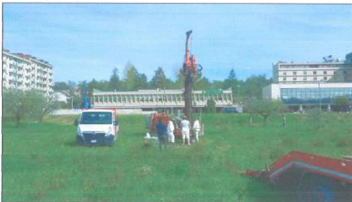
Punto fotografico nr. 3: Esecuzione sondaggio SSI a carotaggio continuo - Vista da sud.
