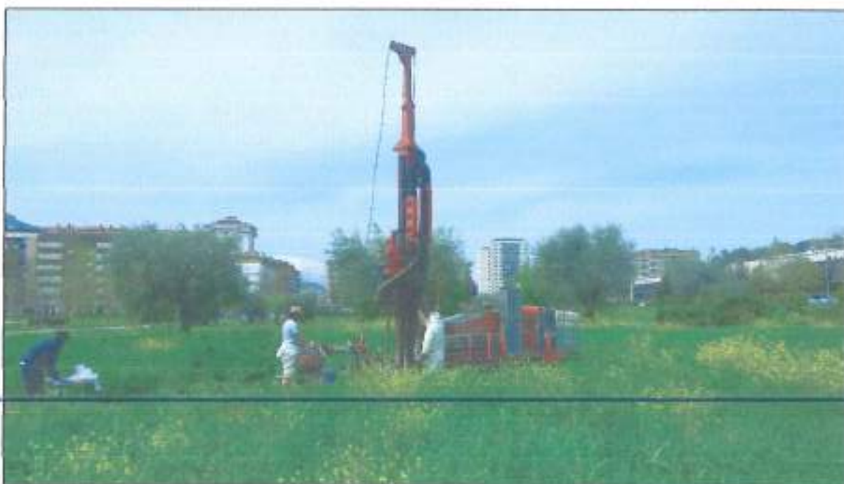
Punto fotografico nr. 10: Esecuzione sondaggio SS3 a carotaggio continuo - Vista da est
