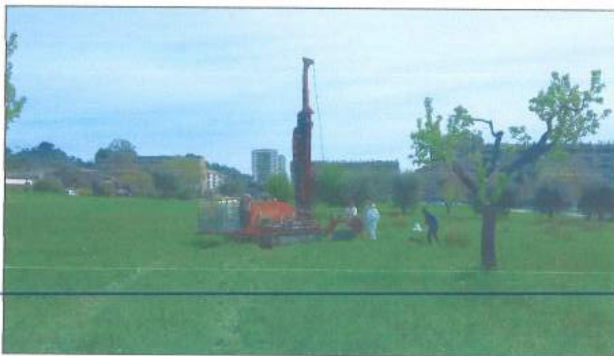
Punto fotografico nr. 8: Esecuzione sondaggio SS2 a carotaggio continuo - Vista da ovest.
