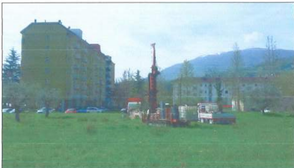
Punto fotografico nr. 1: Esecuzione sondaggio SS1 a carotaggio continuo - Vista da nord.
