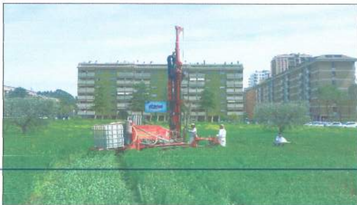
Punto fotografico nr. 16: Esecuzione sondaggio SS4 a carotaggio continuo - Vista da ovest.
