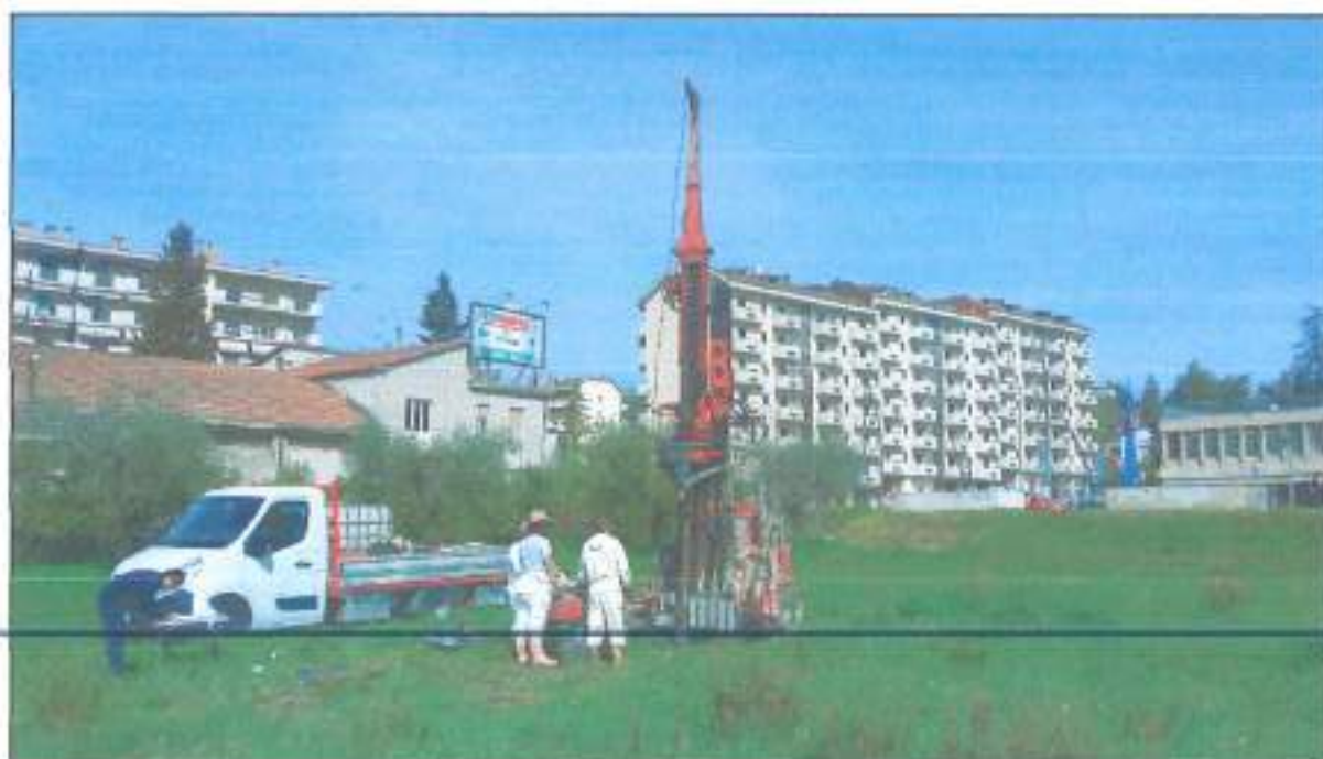
Punto fotografico nr. 2: Esecuzione sondaggio SS1 a carotaggio continuo - Vista da sud-est.
