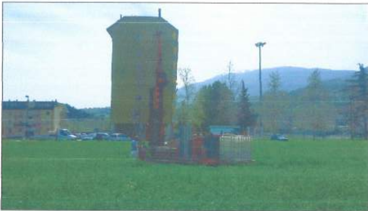
Punto fotografico nr. 13: Esecuzione sondaggio SS4 a carotaggio continuo - Vista da nord.
