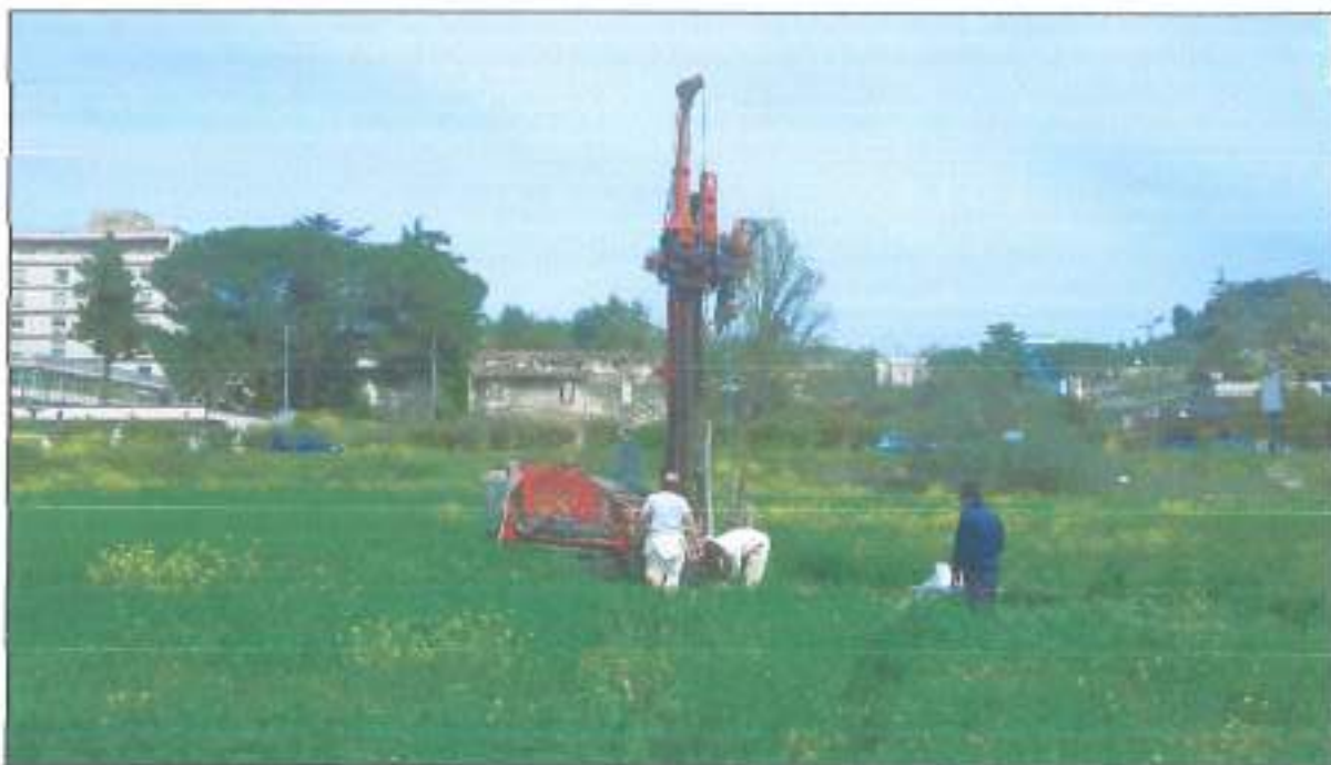
Punto fotografico nr. 11: Esecuzione sondaggio SS3 a carotaggio continuo - Vista da sud.
