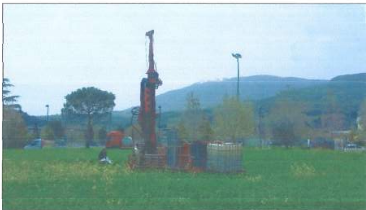
Punto fotografico nr. 9: Esecuzione sondaggio SS3 a carotaggio continuo - Vista da nord
