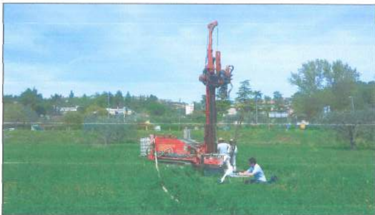
Punto fotografico nr. 15: Esecuzione sondaggio SS4 a carotaggio continuo - Vista da sud.
