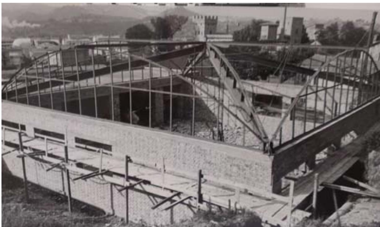
*Vista fase montaggio struttura in acciaio a vela palestra Lotta\_Judo inizio 1967 (impresa CIM di Cappelli Adelmo)
