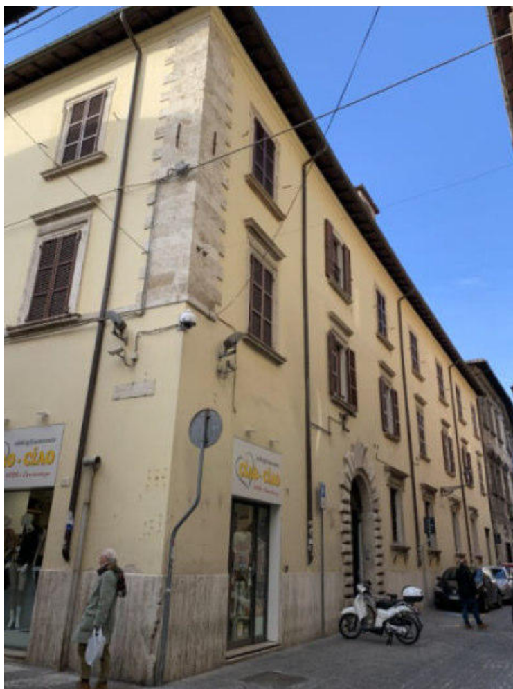
Fig. 1 – L'Edificio in oggetto in cui è inserita la Guardia di Finanza di Ascoli Piceno
