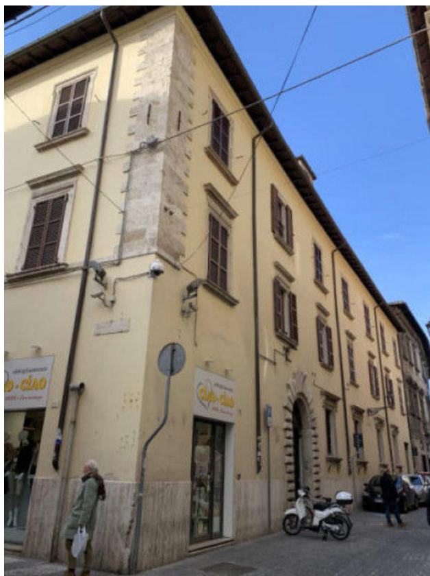
Punto di vista 2 – vista dell'Edificio angolo via Dari – corso Mazzini. In primo piano l'ingresso al locale commerciale posizionato al piano terra e il portone di accesso al bene demaniale
