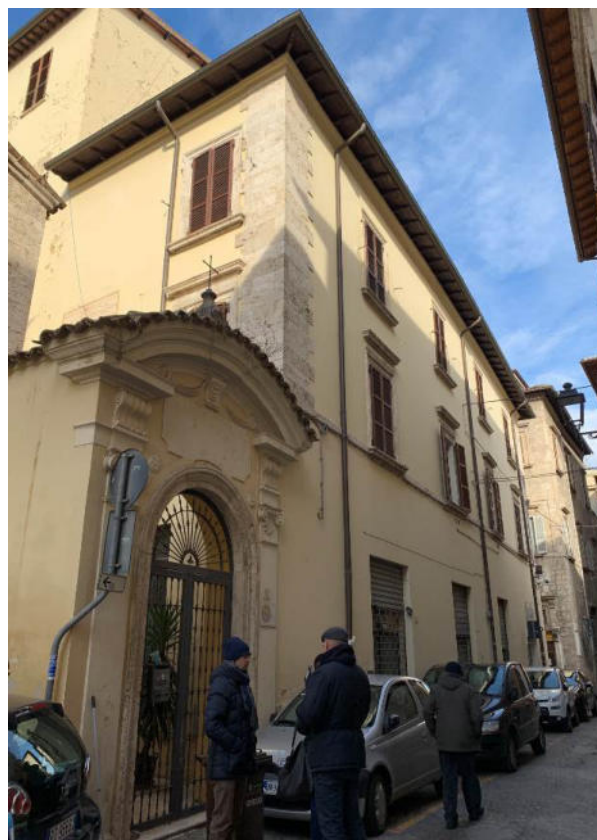
Punto di vista 3 – facciata dell'Edificio su via Dari. In primo piano il cancello di ingresso alla proprietà ecclesiale ad uso dell'Azione Cattolica
