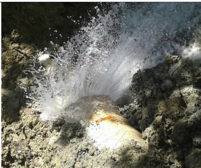
Sisma 2016: Rottura condotta Acquedotto Pescara
