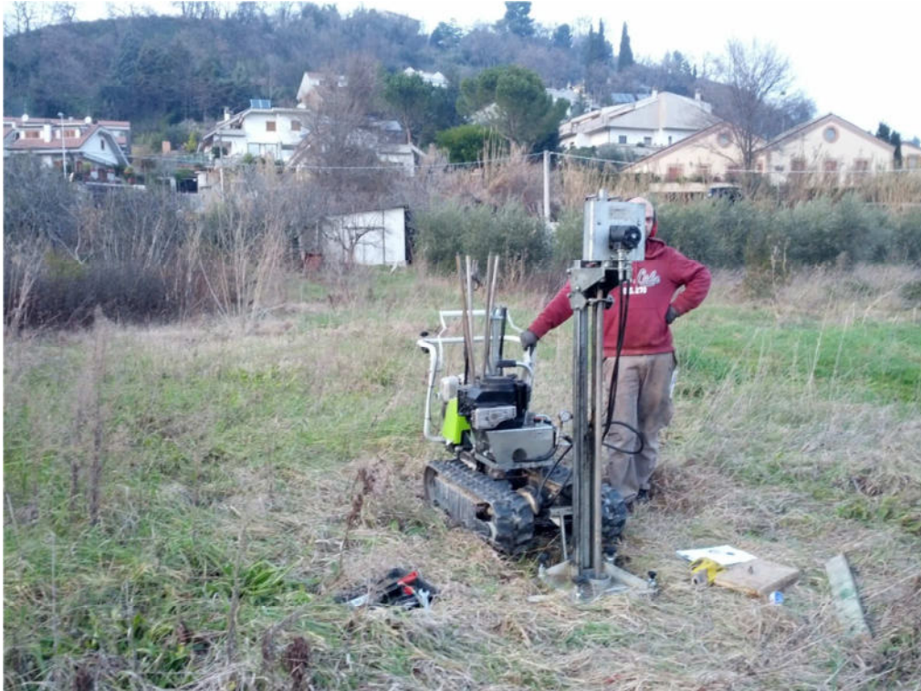
Ubicazione Prova penetrometrica N.1
