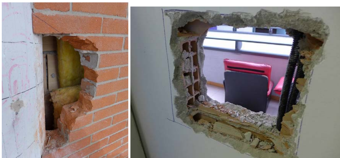
Saggi su tamponature esterne e tramezzi
