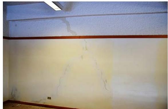
Tramezzi (traccia riparazioni successive)
