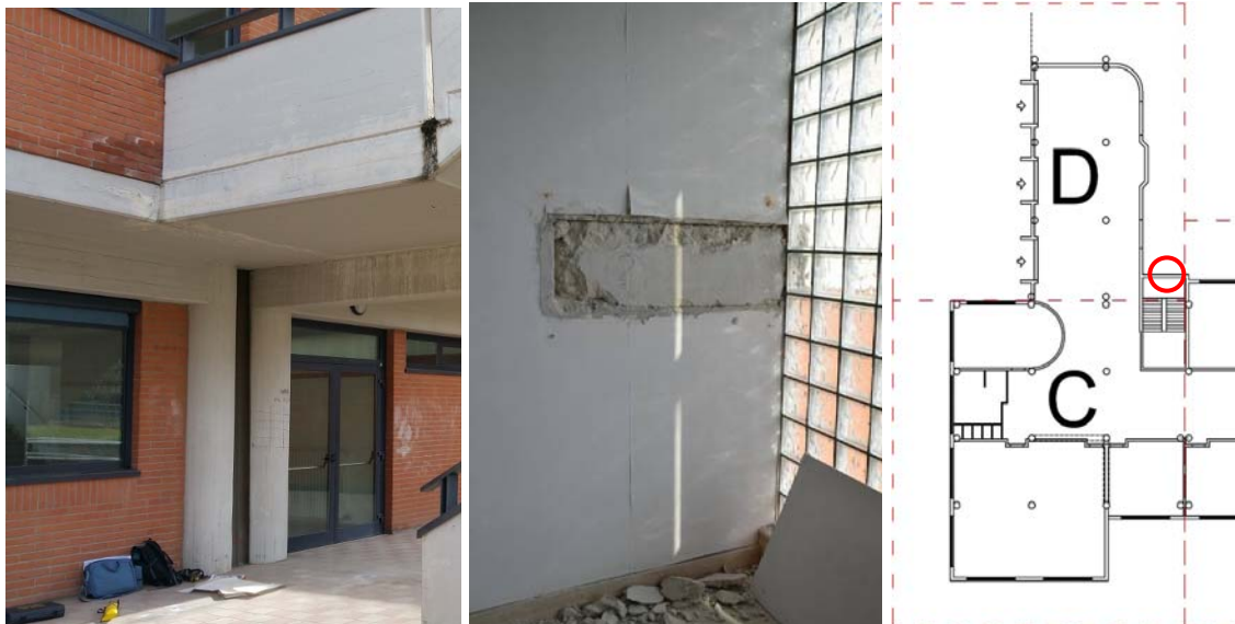
Getto in adiacenza della scala e trave tagliata sul setto della scala del corpo C
