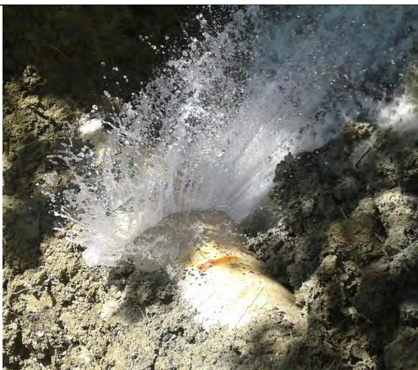
Sisma 2016: Rottura condotta Acquedotto Pescara
