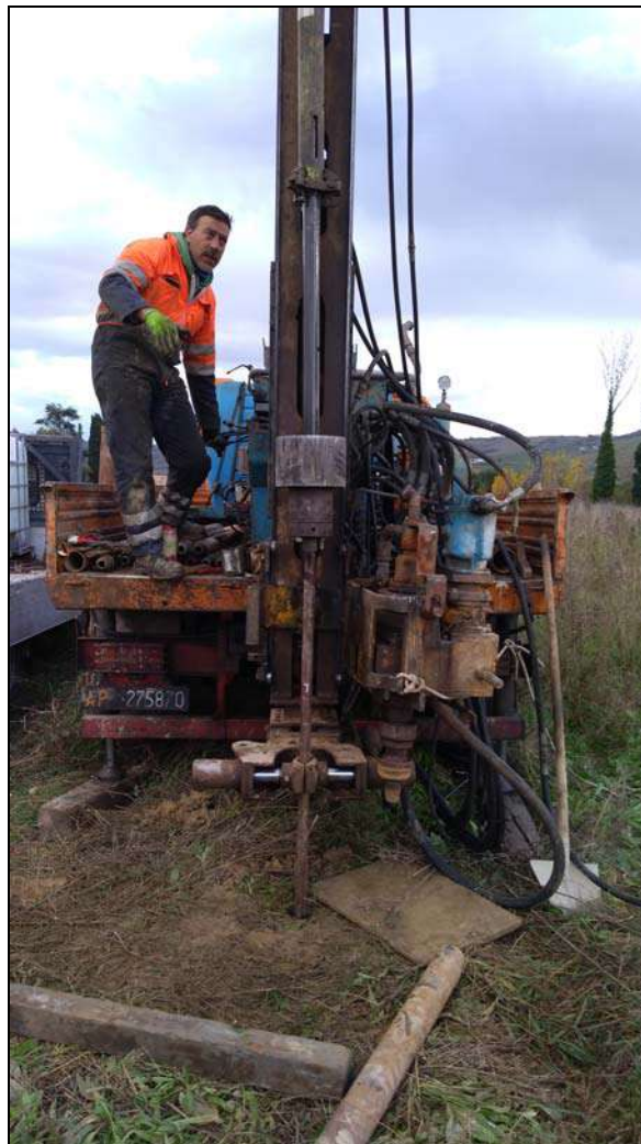
Foto 3 – Misura SPT nel corso del sondaggio S1.
