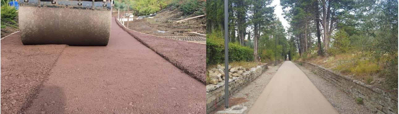
La pavimentazione della pista ciclabile sarà drenante ecocompatibile ed ecologica ottenuta mediante riporto di miscela con aggregati monogrunulari così da mantenere il collegamento tra la superficie e il sottosuolo, eliminando lo scorrimento di acqua superficiale.
