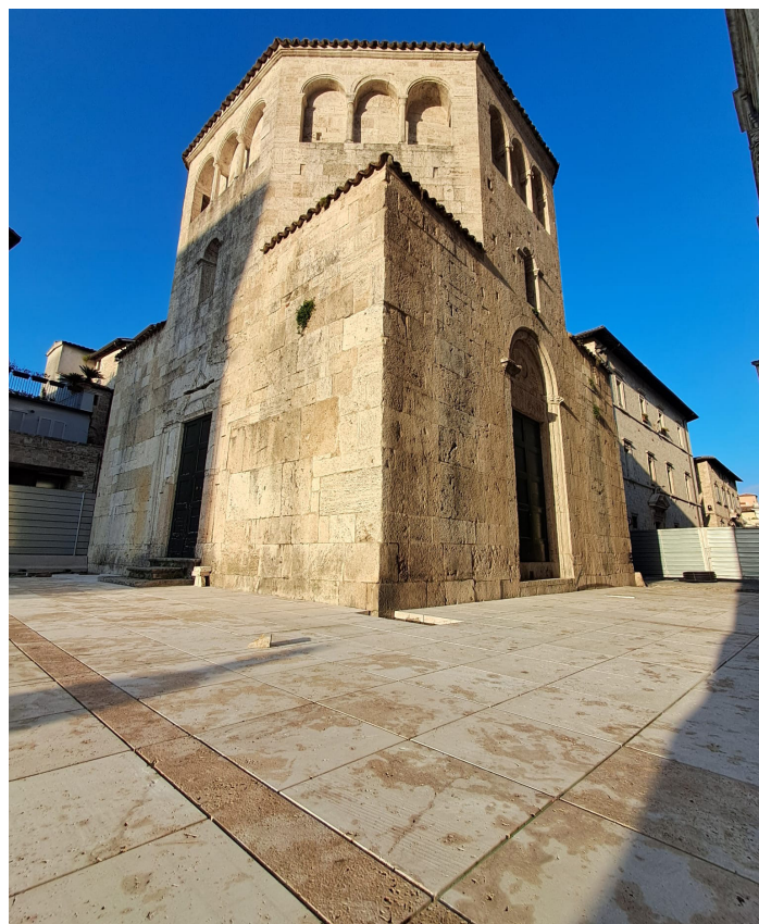
Un dettaglio della nuova pavimentazione nei pressi del Battistero
