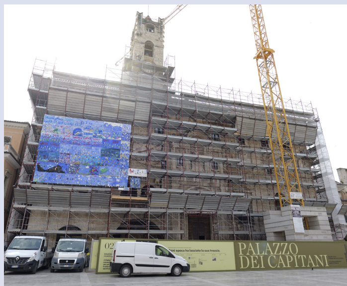
Il cantiere con l'opera degli studenti "Save Water Save World"
