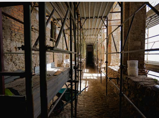
Il cantiere all'ex Caserma Vecchi
