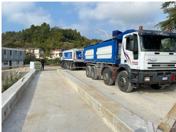
I lavori a Brecciarolo
