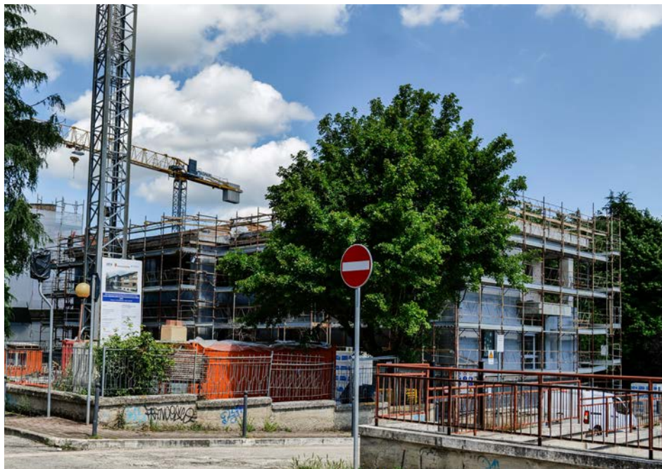
Lavori in via di ultimazione per la scuola primaria Tofare
