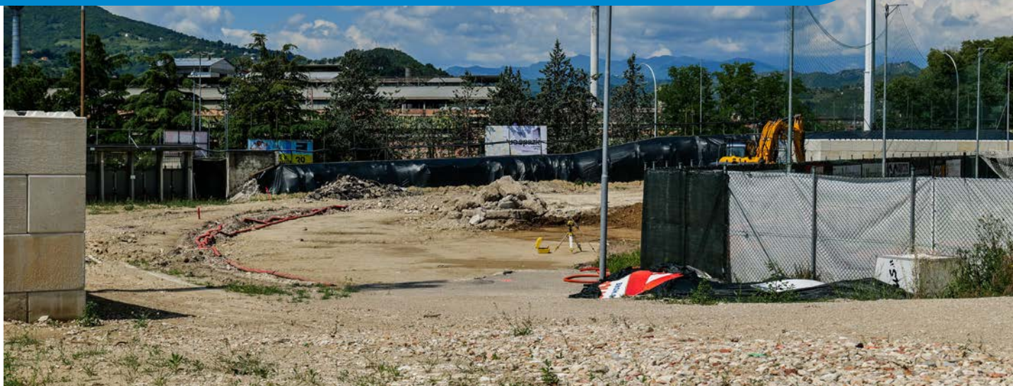
La curva Sud demolita
