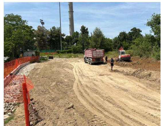
Lavori in corso per la nuova opera
