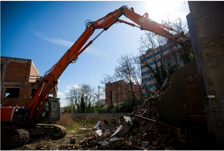
La demolizione al Pennile di Sotto
