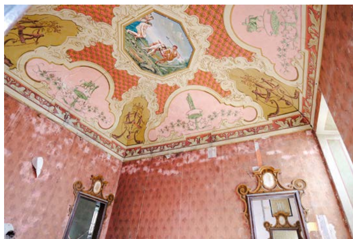
Lavori in corso a Palazzo Saladini Pilastrì
