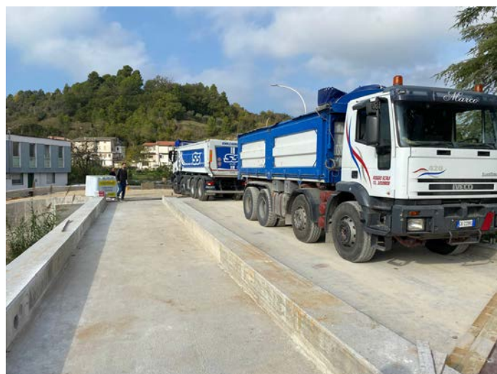
I lavori a Brecciarolo
