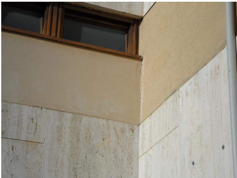
Foto 1– Lesione sulla tamponatura nel punto di intersezione fra facciata Sud e sbalzo del blocco bagni
