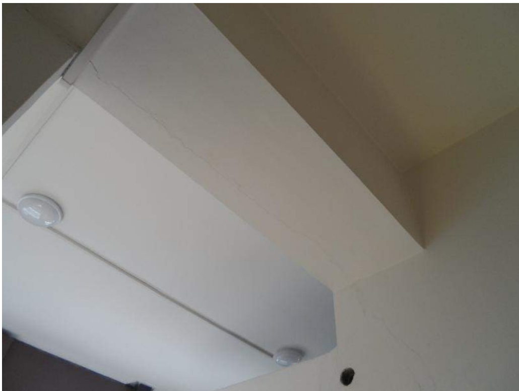
Foto 6 – Lesione sulla tamponatura interna del blocco bagni lato Nord
