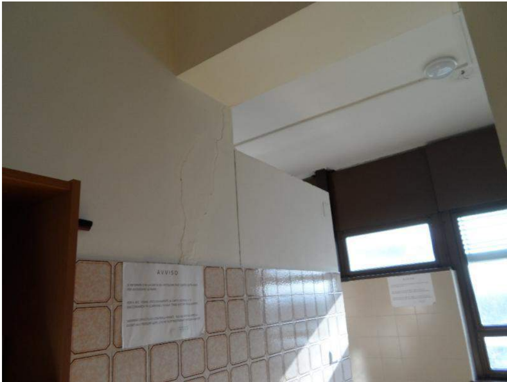
Foto 5 – Lesione sulla tamponatura interna del blocco bagni lato Nord
