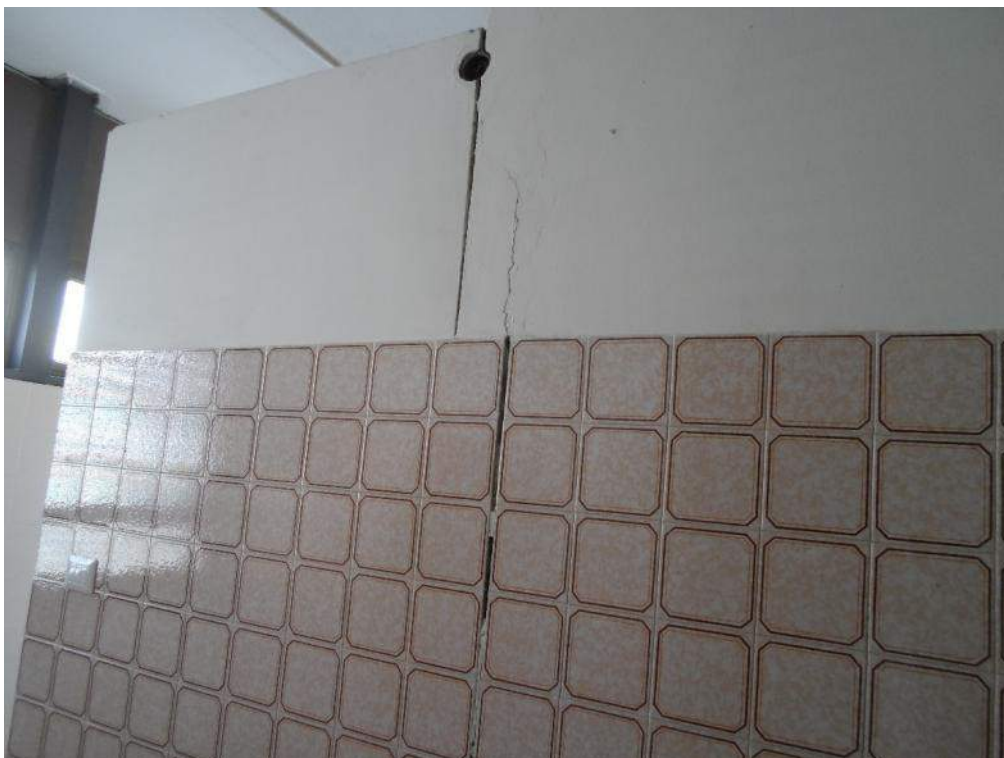
Foto 3 – Lesione sulla tamponatura interna del blocco bagni lato Sud
