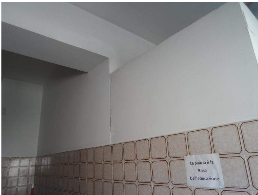
Foto 7 – Lesione sulla tamponatura interna del blocco bagni lato Sud
