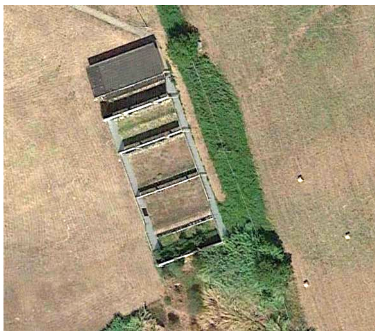
Figura 9: stand di tiro attuale, si nota l'assenza di copertura per gran parte dell'impianto.
