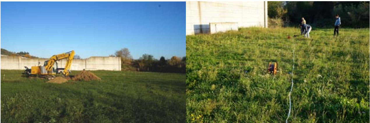
Figura 1 : esecuzione scavo S2 e stendimento sismico nel sedime di progetto.
