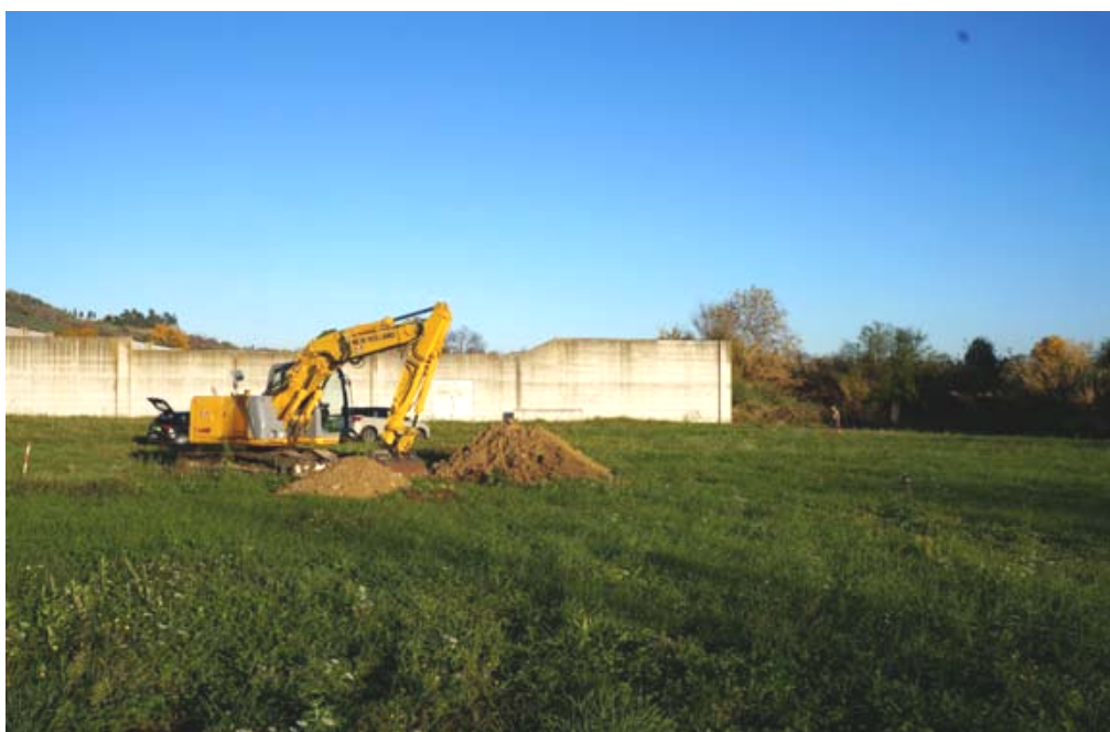
Figura 13: esecuzione saggio S2 escavatore new Holland E 145
