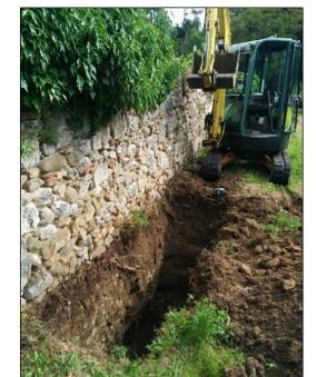
Foto n°4: La foto presa da Nord-Ovest, mostra l'escavatore durante l'esecuzione del sondaggio esplorativo Se1
