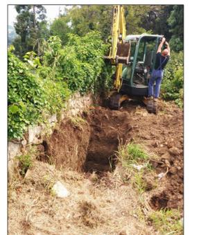
Foto n°6: La foto presa da Nord-Ovest, mostra l'escavatore durante l'esecuzione del sondaggio esplorativo Se2
