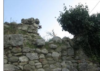
Foto n°3: La foto, mostra un particolare della testa del muro, interessata quasi totalmente da crolli e forte ammaloramento.
