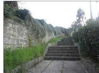
Foto n°1: La foto presa da Sud, mostra il muro oggetto di intervento che dalla strada per il complesso dell'Annunziata prosegue verso la torre del Cuoco; da notare la fitta vegetazione che interessa la parte alta del muro.
