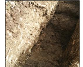
Foto n°5: La foto mostra lo scavo del saggio esplorativo Se1, dove si rileva la presenza del paramento murario dell'appoggio costituito da materiale eterogeneo e le sabbie limose che costituiscono il substrato geologico.
