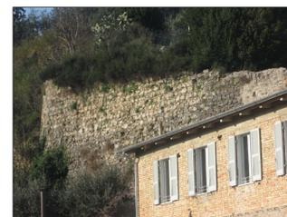
Foto n°3: La foto è un particolare della foto n°1 e mostra la porzione di muro verso Ovest. Oltre alla vegetazione presente in sommità, si rileva un forte dilavamento della malta, oltre la perdita in diverse zone di conchi del paramento. A destra della foto si nota la stuccatura in malta di cemento da rimuovere.
