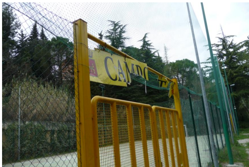
Recinzione e cancello di ingresso manomessi
