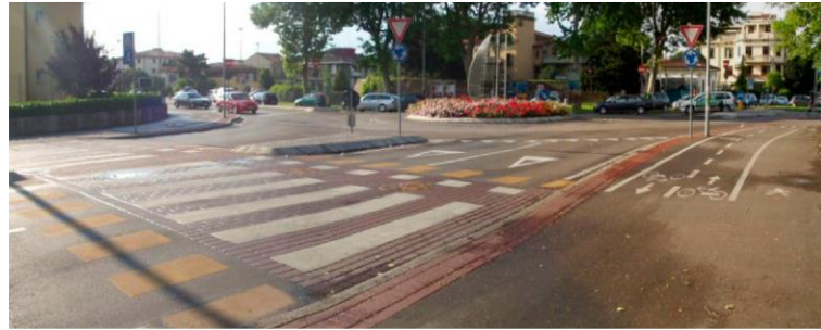
Figura 4 Attraversamenti a raso
