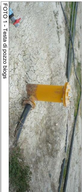
FOTO 1 - Testa di pozzo biogas
