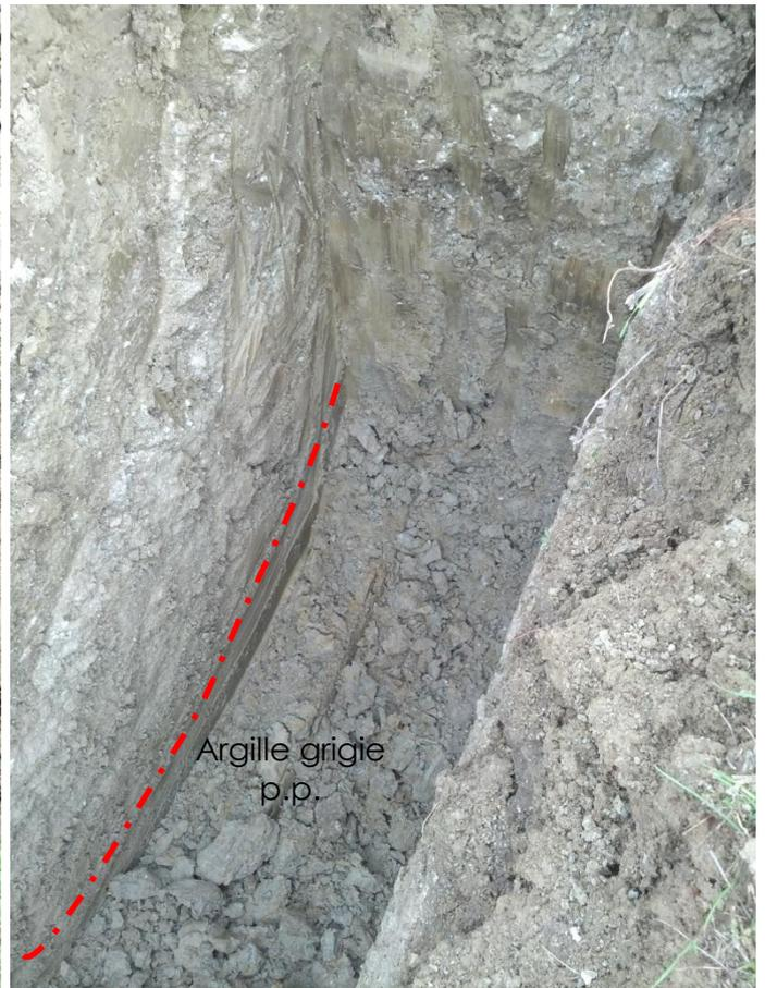
**Foto 10,11,12,13** : Scavo esplorativo Se02, dettaglio progressivo dei terreni affioranti (da alto sx a basso dx).
